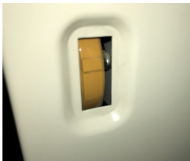
Draaiknop aan de zijkant van de accumulator, wordt bediend door The Box medewerker
